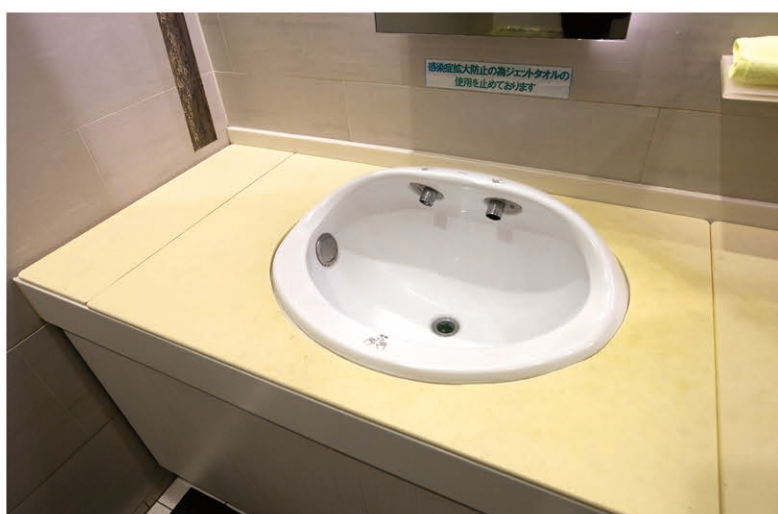
洗面台周りや壁面の黄色い部分が「NeoPlus洗面マット」
